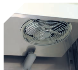
Evaporador de tiro forzado.
