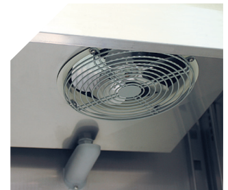
Evaporador de tiro forzado.
